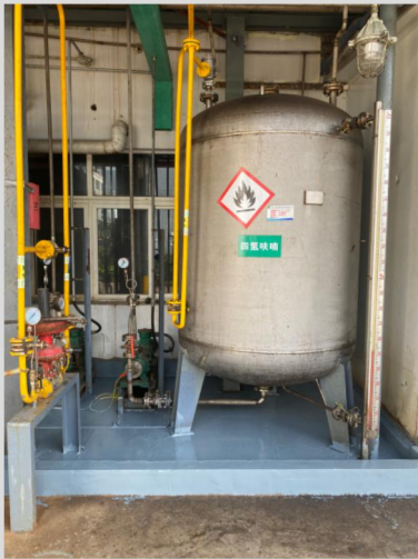
车间外围堰防腐
