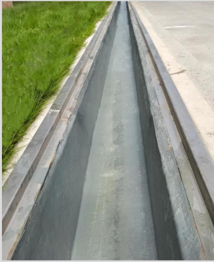
防腐防渗处理沟墙
