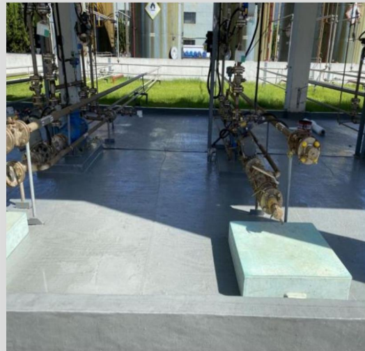
罐区地面防腐
